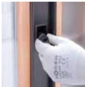
Ruotare le maniglie per sbloccare l'anta secondaria. In questa fase potrebbe essere necessario tenere l'anta in spinta verso il telaio per agevolare lo sgancio dei catenacci.
