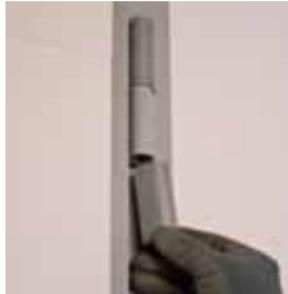
Con una chiave esagonale da 6 mm regolare la porta in altezza agendo sul grano filettato delle cerniere telaio.
